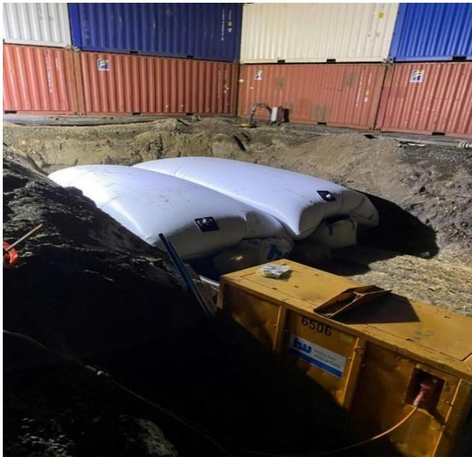
Abbildung 3: Eine mit Container eingebaute und zur Sprengung vorbereitete Fundstelle. Foto: KBD
