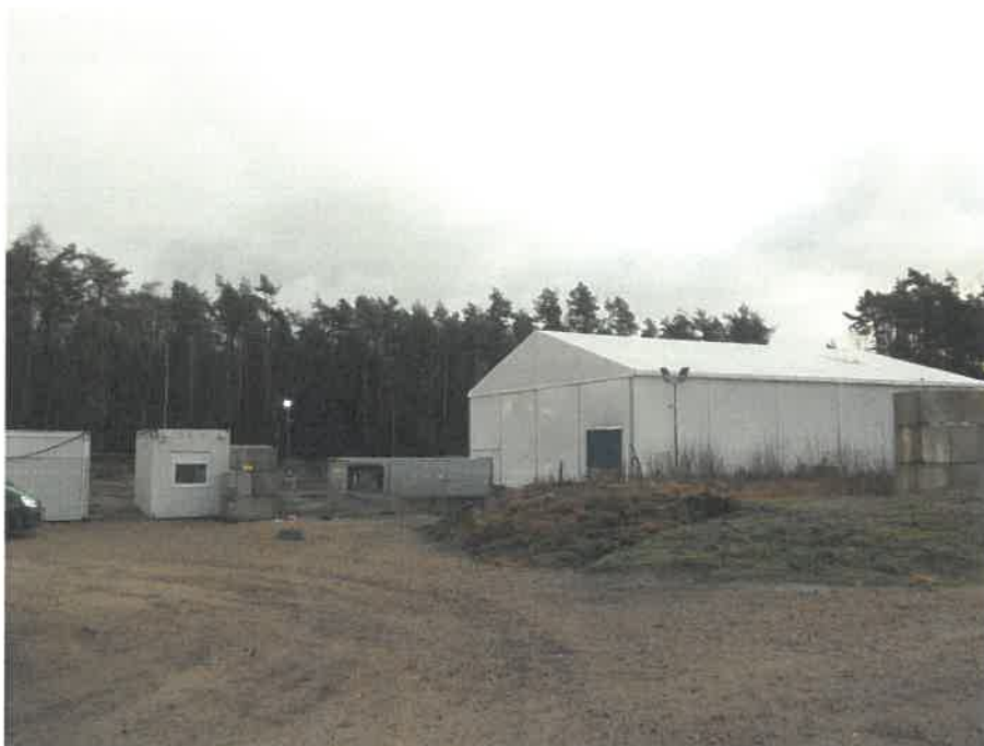
Abb. 9: Überdachung der Räumstelle am „Dethlinger Teich“
