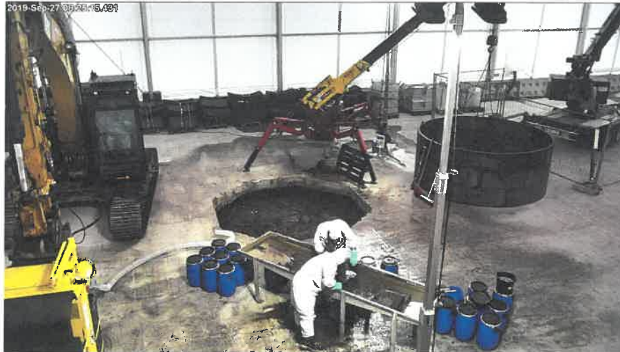
Abb. 10: Räumstelleneinrichtung und Vorbereitungsarbeiten am „Dethlinger Teich“ Foto: LK Heidekreis
