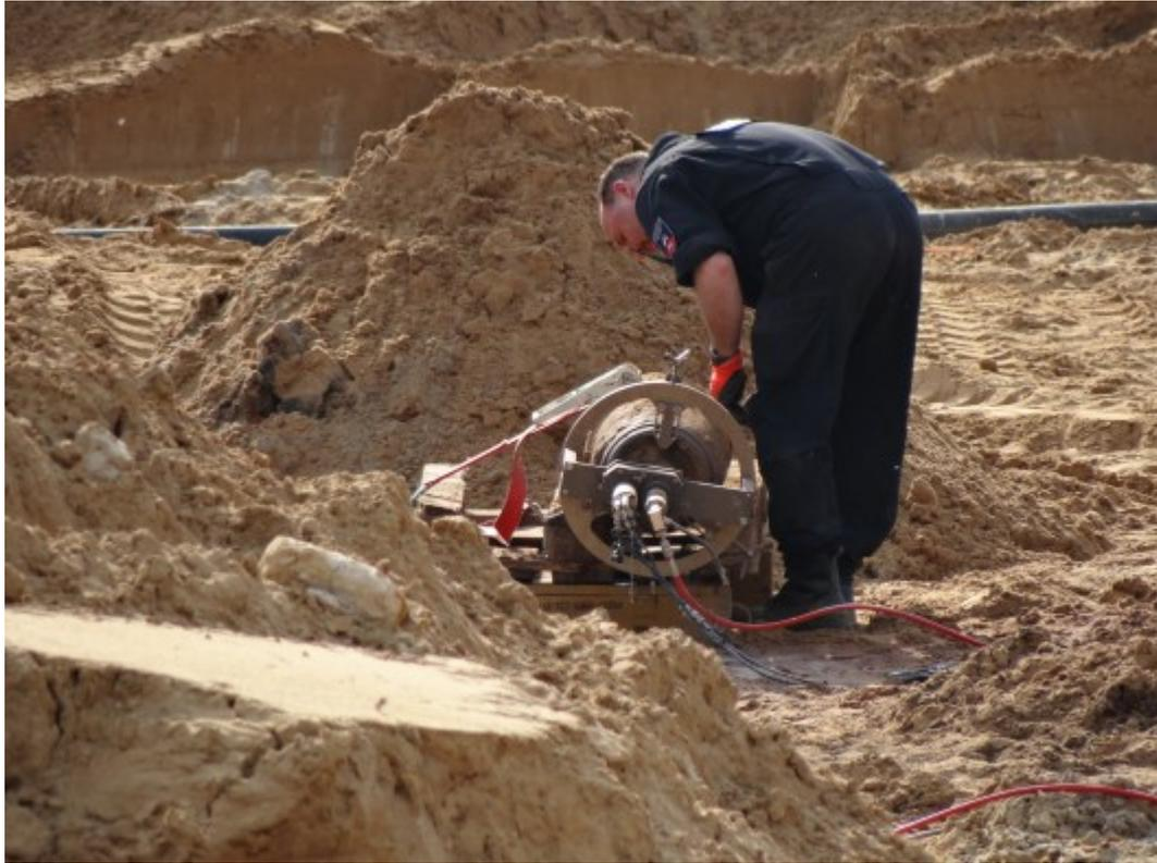
Abb. 7: Vorbereitung auf den Einsatz der Wasserstrahlschneidanlage
